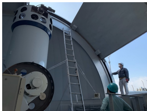
天体ドーム保守点検の様子
